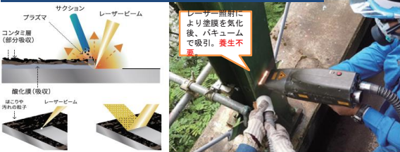
高密度レーザー光を用いた塗膜除去技術の提案
